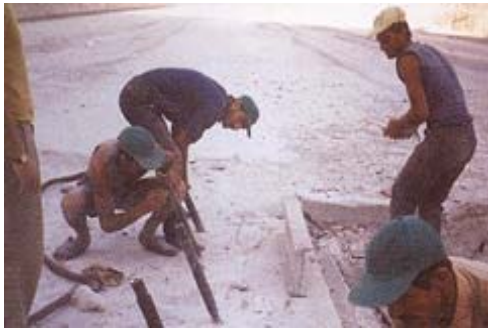
Presa de Keban, Este de Turquía Rotura de 4 canales de 6.5m de anchura cada uno a través de los aliviaderos de la presa.
