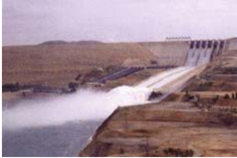
Presa de Keban, Este de Turquía Rotura de 4 canales de 6.5m de anchura cada uno a través de los aliviaderos de la presa.
