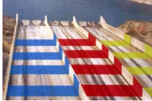
Presa de Keban, Este de Turquía Rotura de 4 canales de 6.5m de anchura cada uno a través de los aliviaderos de la presa.
